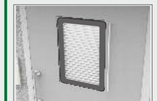
Частичное остекление полотна с установкой жалюзи
